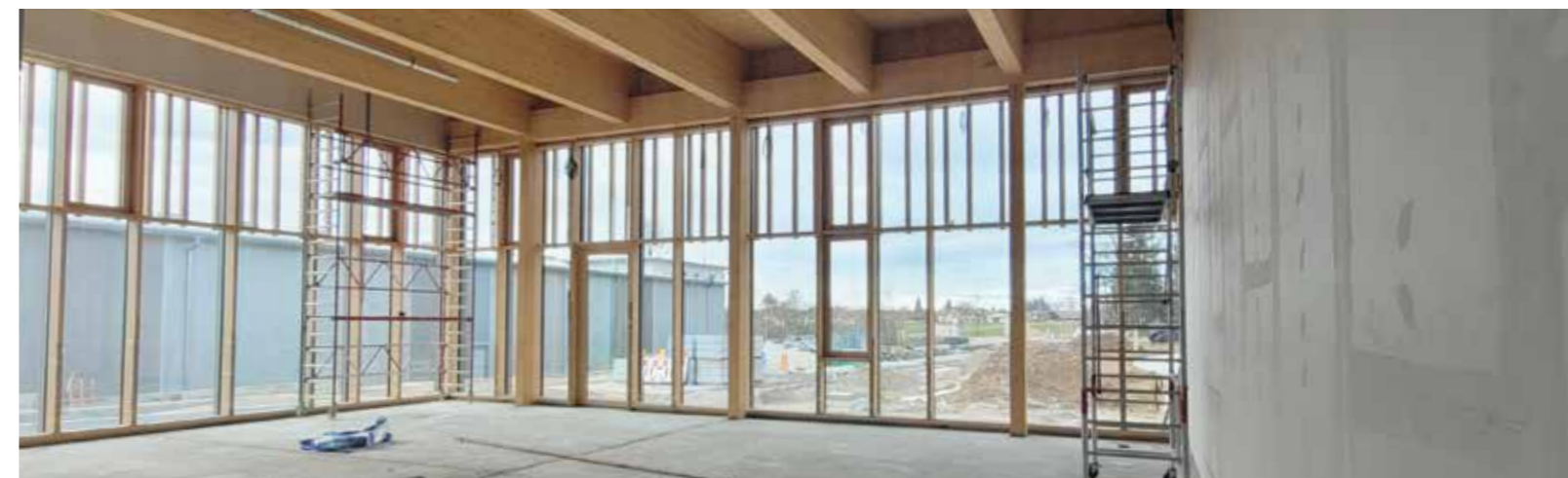
OBEN: INNENAUSBAU DER NEUEN WERKSTÄTTE. UNTEN: DER NEUBAU IN DER ENTSTEHUNGSPHASE.
