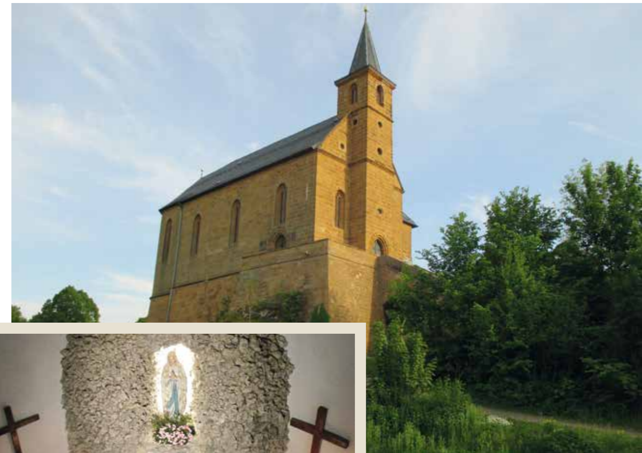
BILD 1: STATISCHE SANIERUNG DER AUF FELS GEBAUTEN WALLFAHRTSKIRCHE
